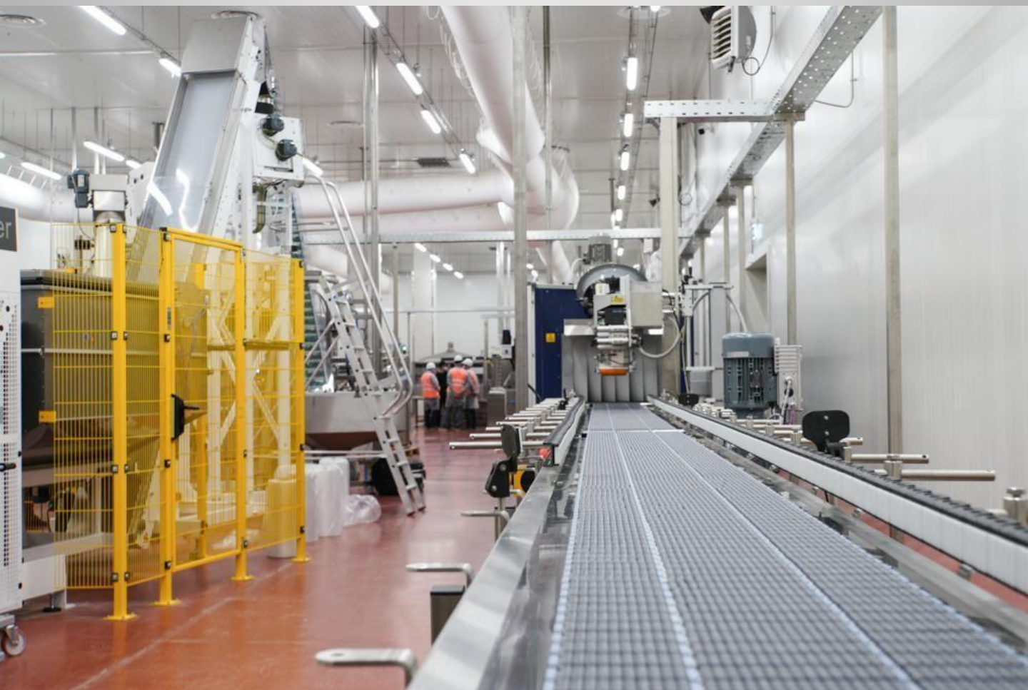
На фото: Торгово-распределительный центр ТК «Мираторг» в г. Домодедово Московской области. Потолок выполнен с использованием системы подвесных потолков для сэндвич-панелей DAARTS Coolroom
