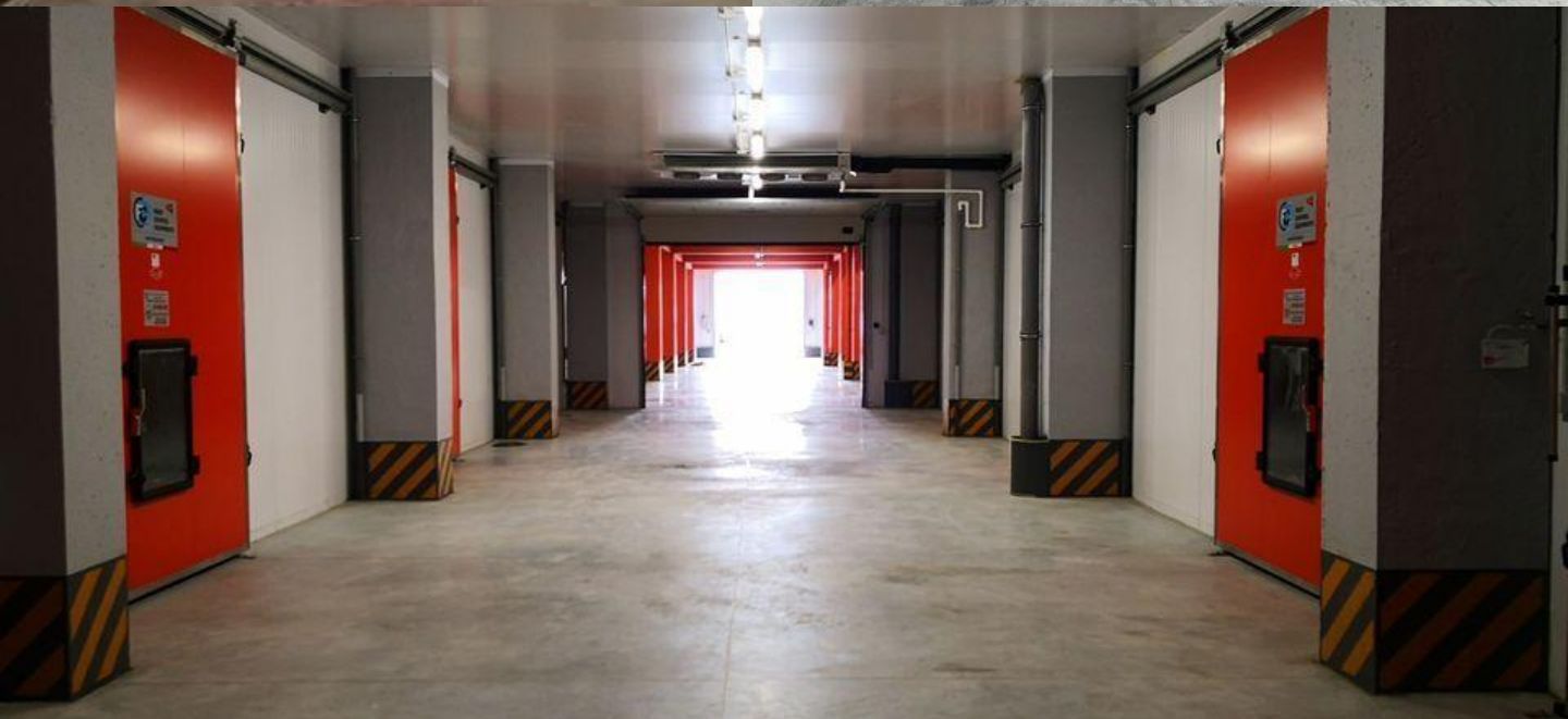
На фото: Фруктохранилище компании Green Farmer, Армения. Потолок выполнен с использованием системы подвесных потолков для сэндвич-панелей DAARTS Coolroom
